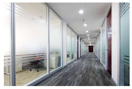
108博瑞克系列单玻,墙体框架由铝合金型材组成,网状龙骨成井字连接保证了墙体整体结构的稳定性,墙体面板由单层10mm防火玻璃组成;
